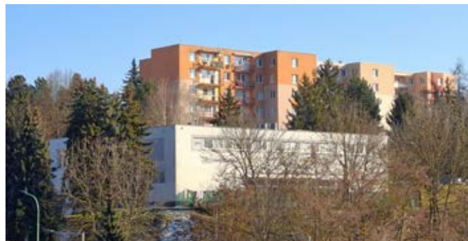
Objekt známy ako Ideál by mal dostať po svojej prestavbe celkom novú tvár.
