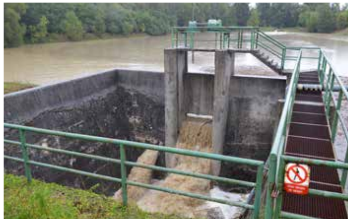
Suchý polder pri myjavskej nemocnici spoľahlivo plnil svoju funkciu pri zachytávaní vody z výdatných zrážok.
