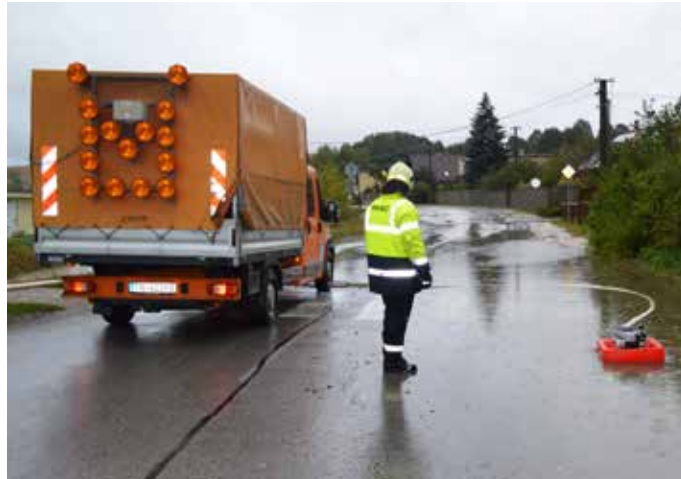
Odčerpávanie vody z pozemku rodinného dvoru na Turej Lúke.
