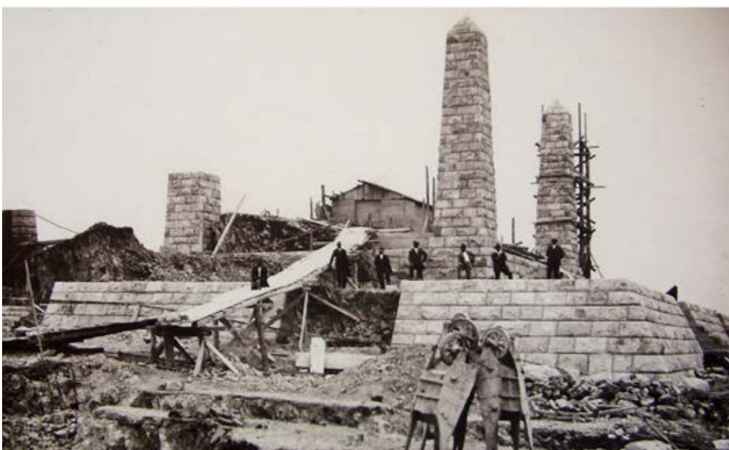
Stavba hornej terasy a pylónov.
