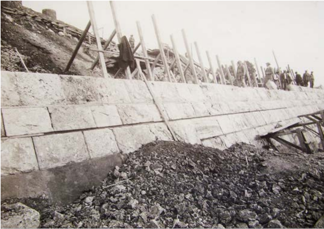
Vonkajší obklad múrov terás tvorili travertínové kvádre. Travertín ťažili v kameňolome na Spiši.
