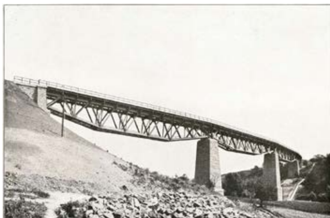
Myjavský viadukt je technickým unikátom a národnou kultúrnou pamiatkou.
